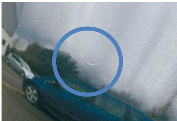
einzelne Kratzbeschädigungen
